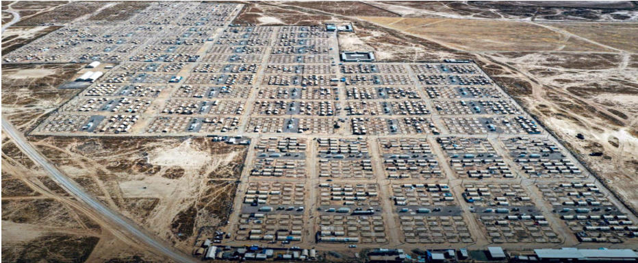
تصویر شماره ۲: پروژه کمپ حاج علی در عراق
